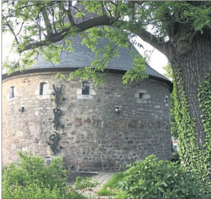
Die Rotunde: Um den Raum, den dieser Turm bietet, besser nutzen zu können, müsste ein zweiter Ausgang gebaut werden.
